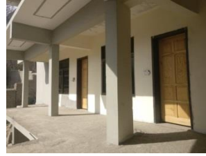
Türen und Fenster sind montiert
